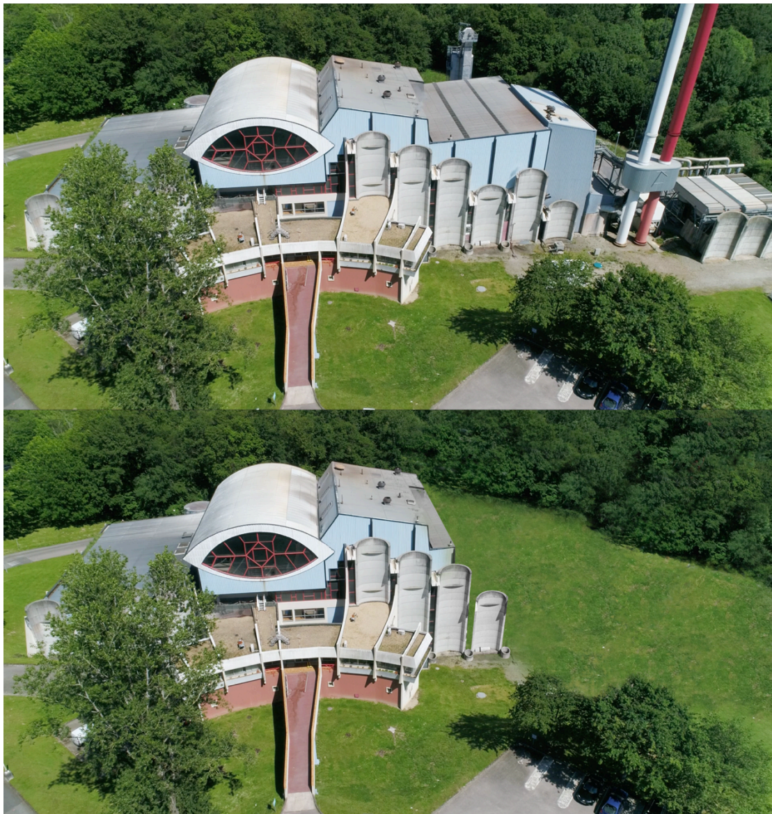
Photomontage de l'usine en ne conservant que le bâtiment administratif, l'œil, la fosse et les coques
